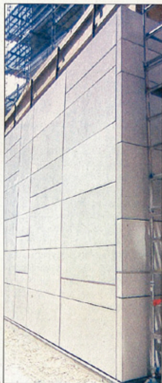
PRØVEMONTASJE på byggeplassen i Malmø. 200 forskjellige former blir produsert til dette prosjektet.
